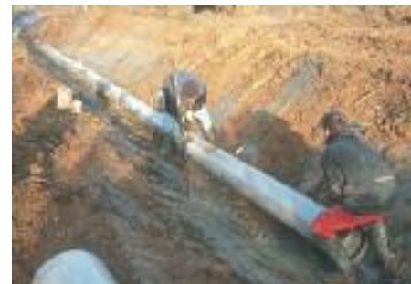
Busage pour création d'un siphon
