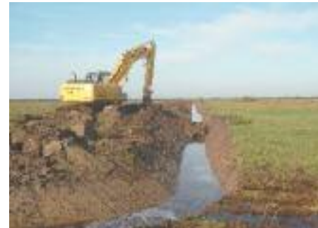
Busage pour création d'un pont
