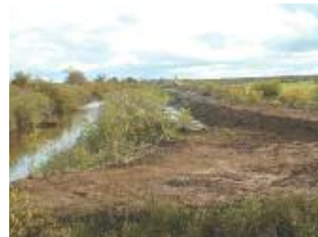
Reprise de la digue
